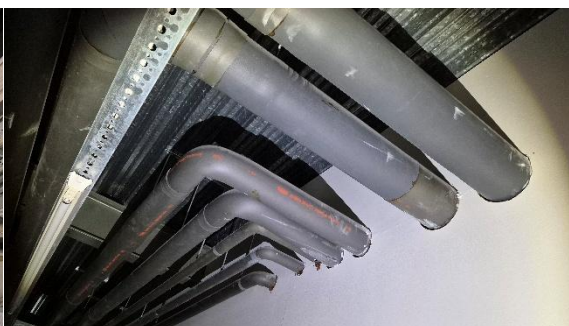
Bilete 13 – Røryisolasjon av cellegummi på plan 02.
