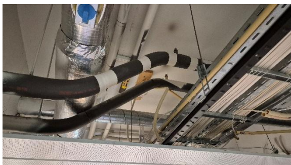
Bilete 12 – Røryisolasjon av cellegummi i korridorar.
