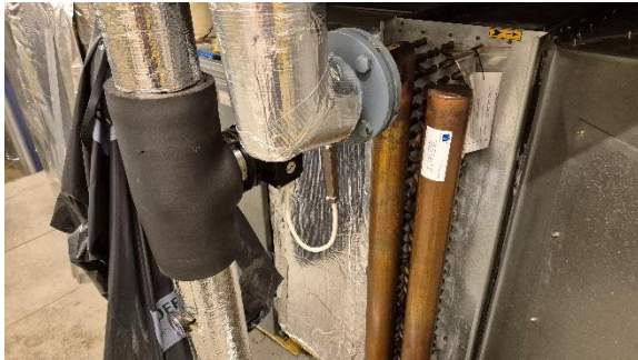
Bilete 20 – Kjølebatteri i ventilasjonsanlegg.
