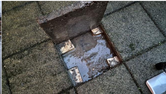
Bilete 9 – Takfolie/membran under betongheller på balkongar.
