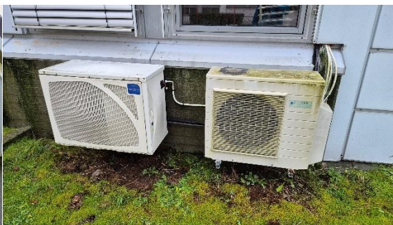
Bilete 15 – Varmepumper på fasade.
