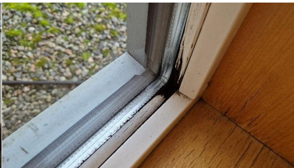
Bilete 5 – Eksempel på eit «oppbrukt» vindaug frå 1980-talet, med råteskadar i karmen.
